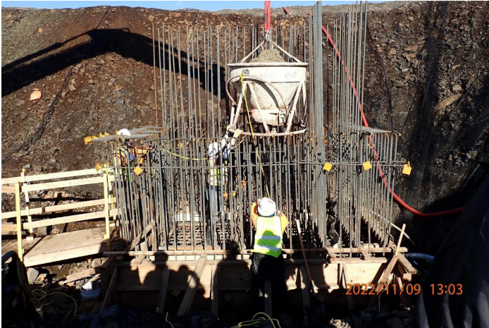
UV building sump – first concrete pour
